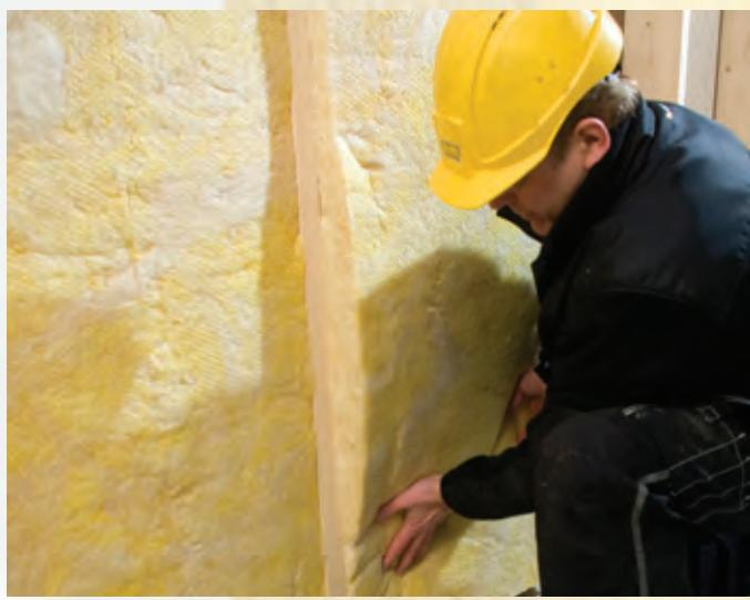
Isolering av vegg med Glava plate
